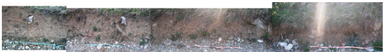
Abb. 25: Südlicher Abschnitt der Baustelle in Blickrichtung W ( x=733035 , y=301687 , z=465m )
